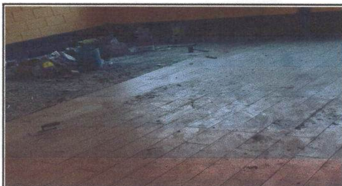
Foto 4: Este es el avance de la colocación del cerámico del piso.
