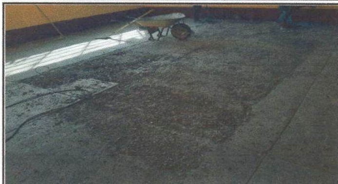
Foto 2: Este es el avance del trabajo del piso de las aulas correspondientes.
